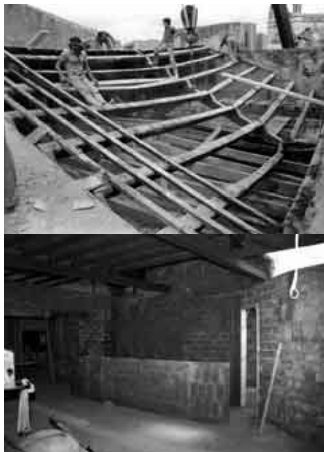
Obres de restauració de la teulada de la casa. A sota, remodelació de la sala que acull el bar a la primera planta de Cal Figarot.
