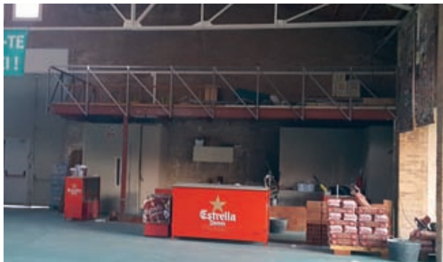
Construcció de l'estructura de la nova barra de bar amb espai elevat. Foto: Jordi Galtés
