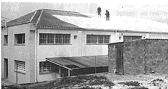
L'impermeïllant en coberta d'una nau industrial
